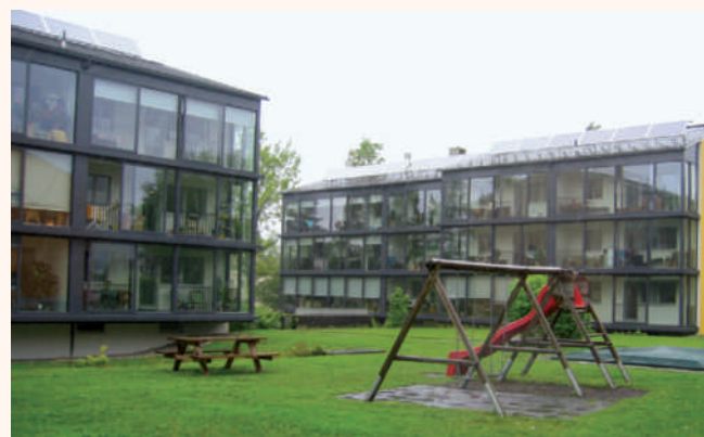
Rénovation de logements sociaux à Dornbirn
